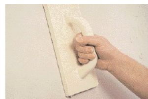
... i po chwili zacieramy tynk packą tynkarską.
