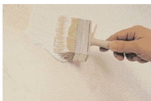
... nakładanie folii ASS2, a po 1 godz. schnięcia ....
