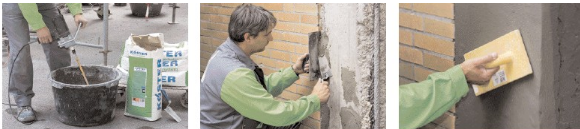
Mieszanie zaprawy, nakładanie i wygładzanie –szybka naprawa z KOESTER Betomor Multi A
