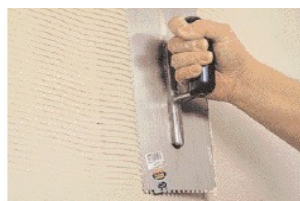
... nałożenie cienkiej warstwy tynku ASS3 ....
