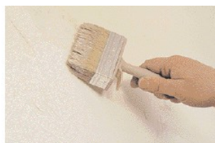
... zagruntowanie ASS1, a po 15 min. ....
