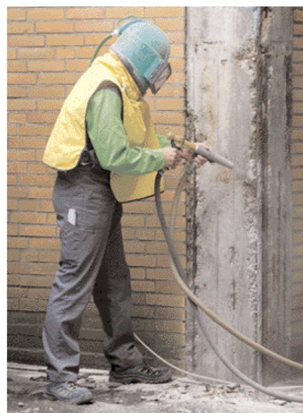
Piaskowanie – czyszczenie stali i betonu
